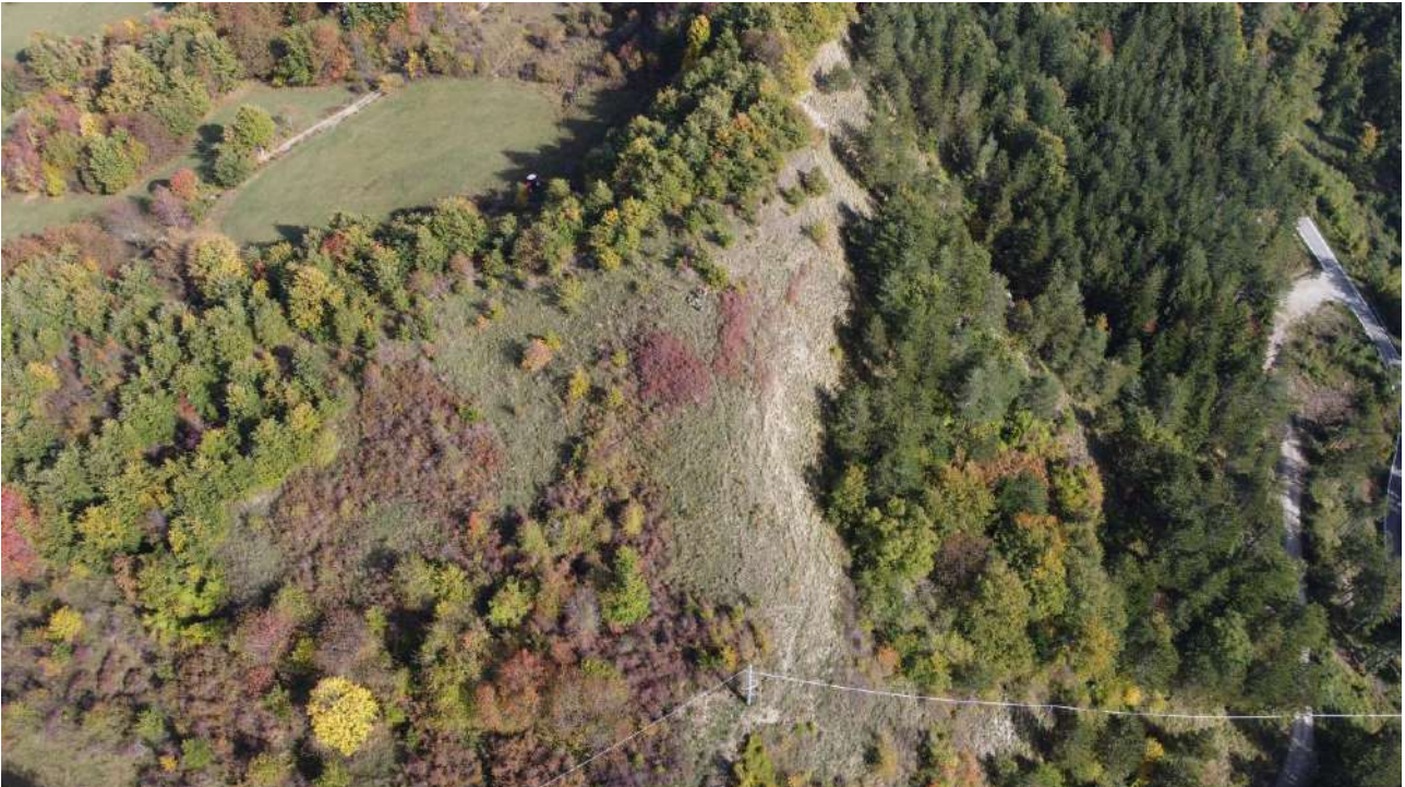
Foto n. 1 rilievo fotografico dell'area di intervento ripresa da Drone _ Stato di Fatto
